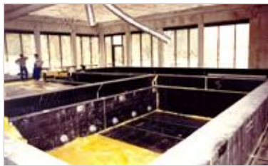
Caoutchoutage sur béton
